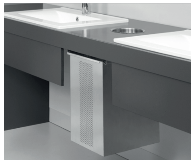
Einbausituation mit Abwurfring im Waschtisch und ohne Verkleidung
